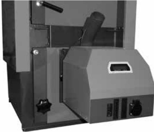
Brenner für Pellets ATMOS A25 in unterer Kammer des Kessels
